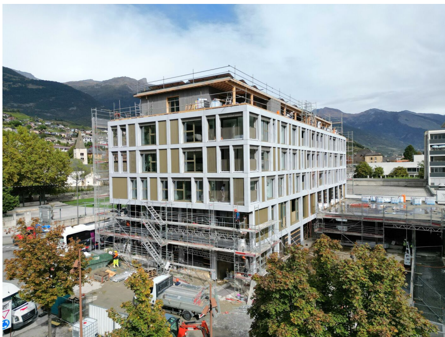
Vue extérieure de l'immeuble
