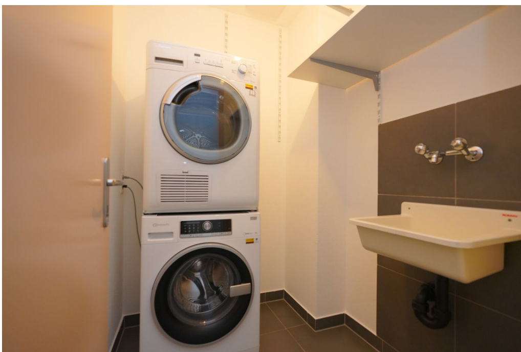
Buanderie privative avec colonne de lavage
