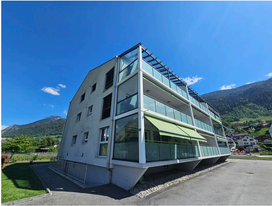
Vue extérieure de l'immeuble
